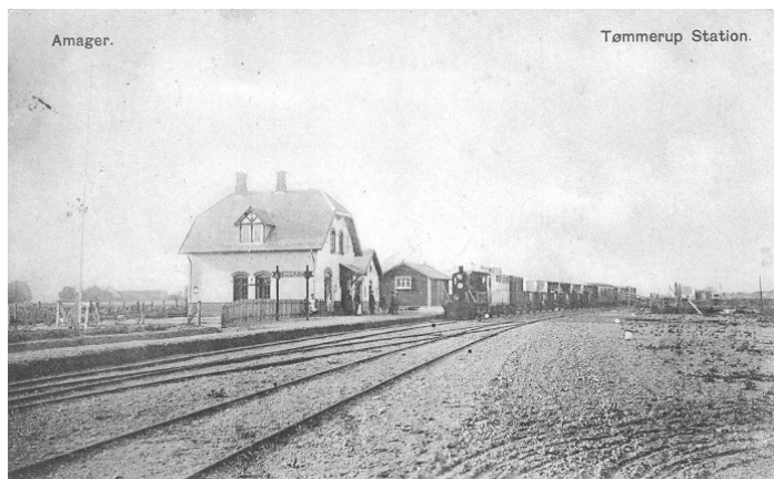
Tømmerup Station fotograferet året efter Amagerbanens indvielse. Foto: 1908.
