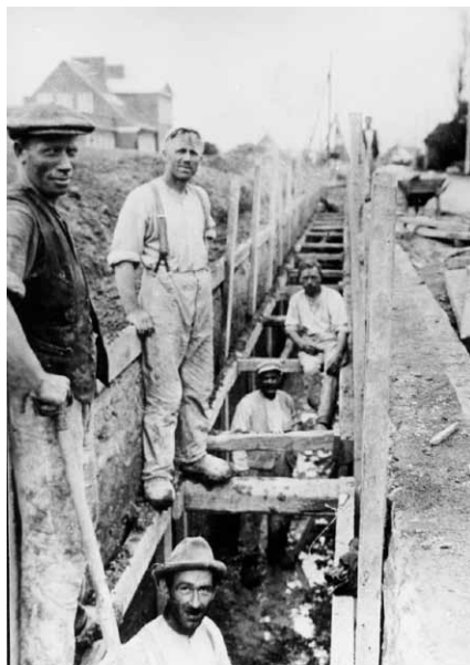
Kloakarbejde ved Amager Landevej ved Korsvejens skole. Ca. 1936
