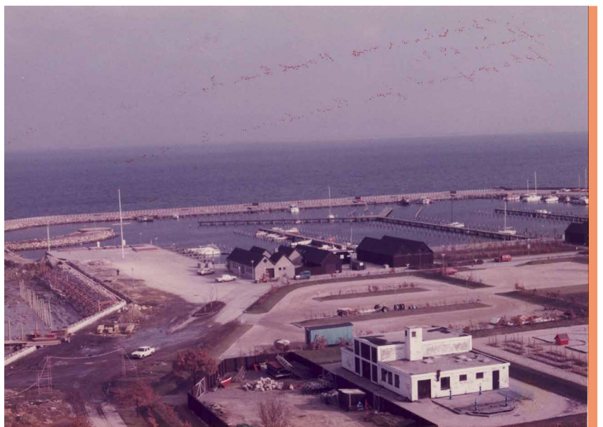
Kastrup nye lystbådchavn under opførelse i 1983
