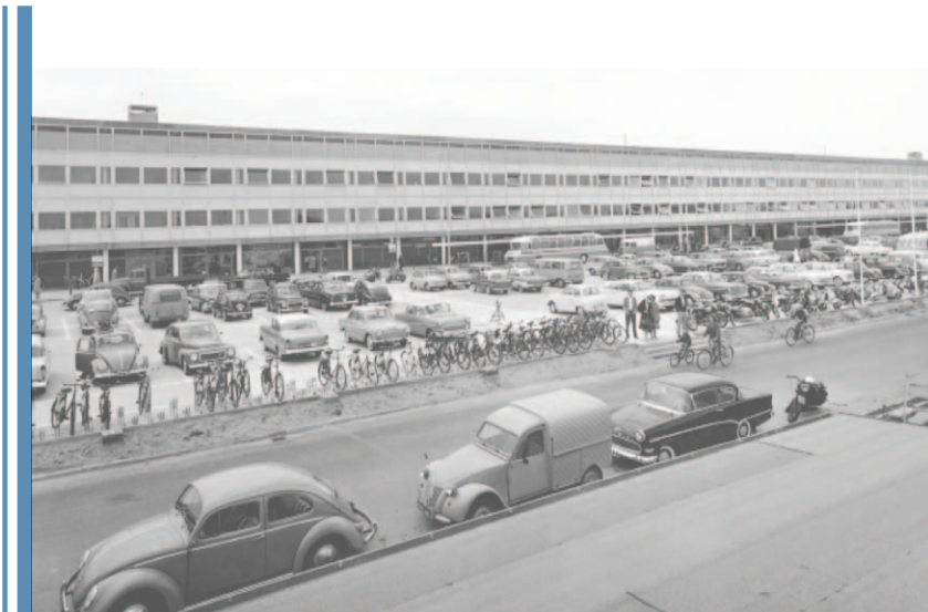
Københavns Lufthavn, Kastrup 1960. Lufthavnsbygningen med parkeringspladsen i forgrunden. Fotograf: Erik Jensen, Scandia Foto.
