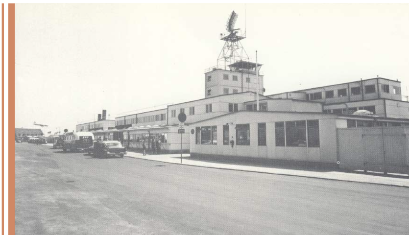
Tårnbygningens nederste etage er den gamle kontrolcentral. Etagen ovenover rummer Indflyvningskontrollen. Øverst Tårnet (glasburet). Faktisk består bygningen af tre etager, hvoraf den allernederste (ikke synlig) var til teknikerne. Foto ca. 1960.
